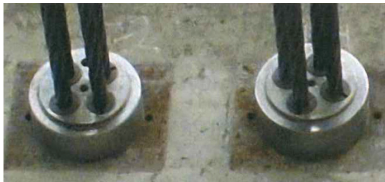
Установка обоймы анкера
